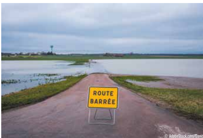
Route barrée route inondée par inondation et bouleversement climatique.
